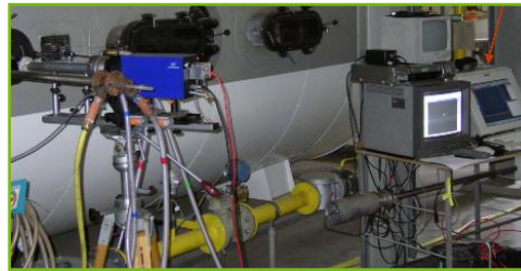
Mobiles System OPTISOS® im Einsatz an einer Thermoprozessanlage
