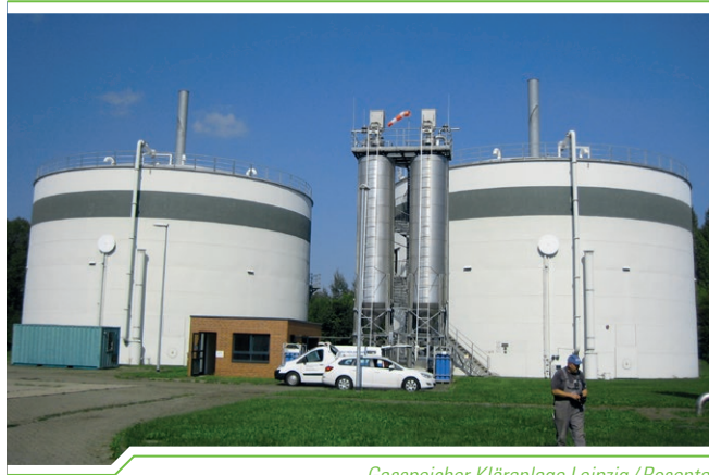
Gasspeicher Kläranlage Leipzig/Rosental
