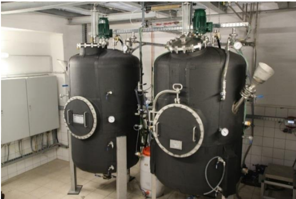
Abbildung 1: Kleintechnische 2 m 3 -Biogasversuchsanlage am DBI - Gastecnologisches Institut gmbH Freiberg
